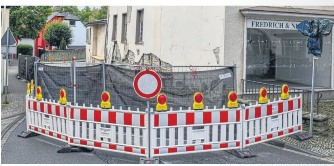
Anlage Foto Sperrung (Quelle: Nitsche)
